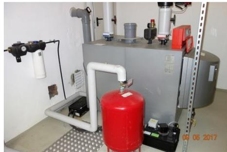
Warmwasserunterbankheizkörper Erdgasbrennwertheizung **in der Kirche**
