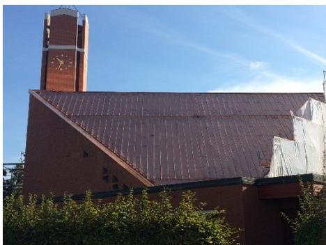
Neues Kupferdach mit Wärmedämmung
