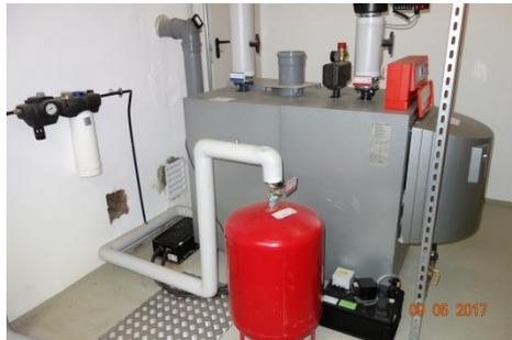
Warmwasserunterbankheizkörper Erdgasbrennwertheizung **in der Kirche**
